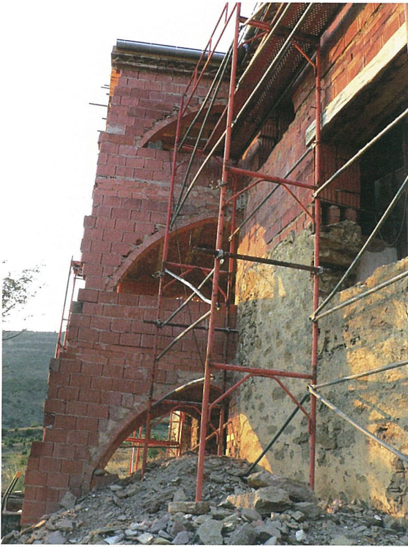
写真44 廃屋を4年かけて改築して民宿をつくる
