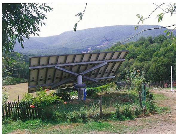
図22 自動太陽追尾式のソーラーパネルがある (農家ホテル・ペルスケネア)
