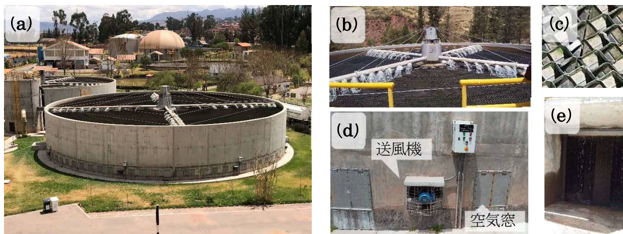
図1 散水ろ床装置 (a) 全体 (b) 散水の様子 (c) 担体 (d) 送風機と空気窓 (e) ろ床内の様子
