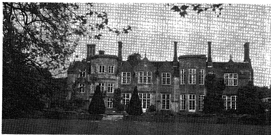
1959年 Miles Laboratories Ltd. による修復後のストウク・コート南西面
