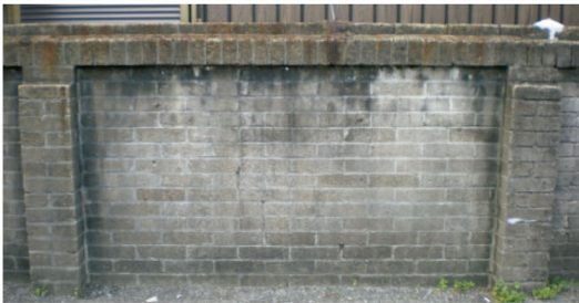
写真 8 控えのある鉾津煉瓦塀の例
