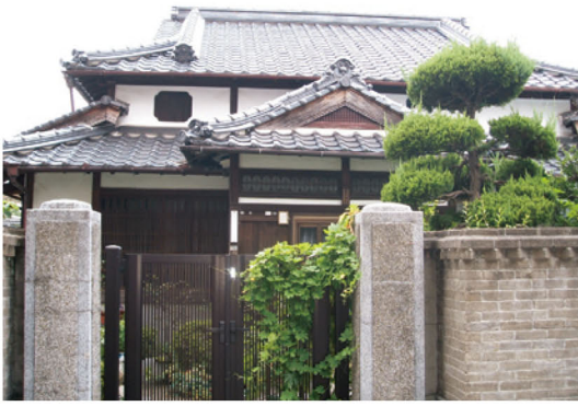
写真 4 下屋を持つ屋根の例 (藤井家住宅)
