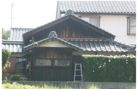
写真1 縦張りの例(恵木本家住宅)
