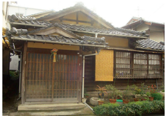
写真2 下見張りの例(久村家住宅)
