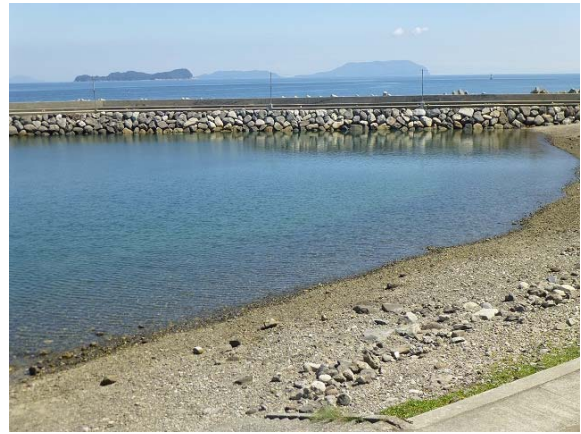
図12 改良された石積みの防波堤
