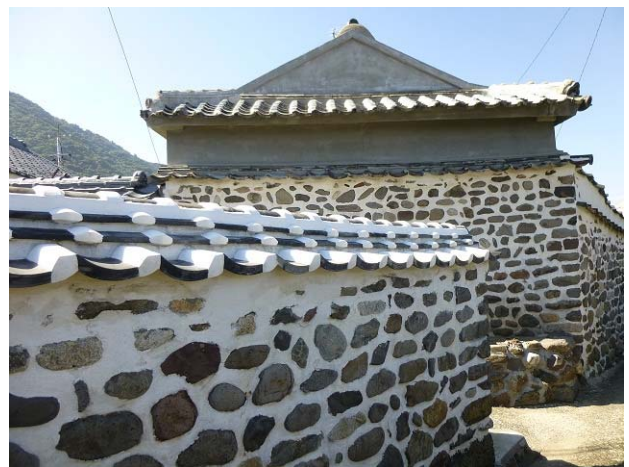
図4 屋根と一体となった練塀
