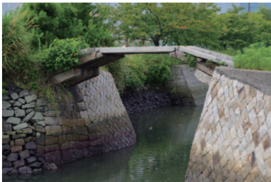
写真2 防府市浜方の枡築欄干橋
