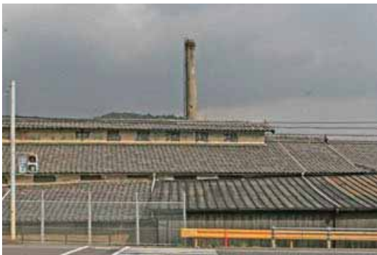
写真2 県道3号線道側から見た中島屋酒造場
