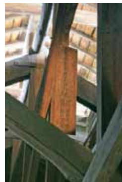
写真8 出荷倉庫棟札
