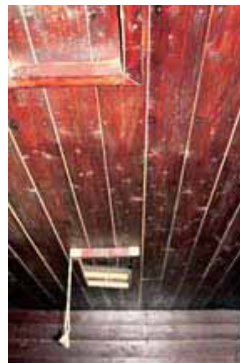
写真3 柿渋塗りの室内部
