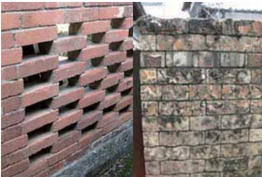
写真9 市松積みの例
