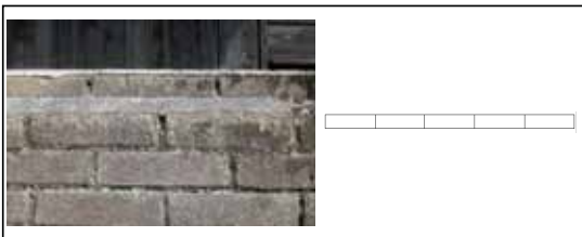
図15 積み方 AI : 中央長手 (モルタル傾斜) (1例)
