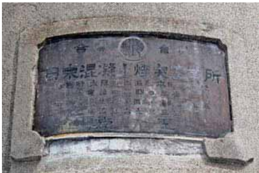
写真5 煙突金属銘板
