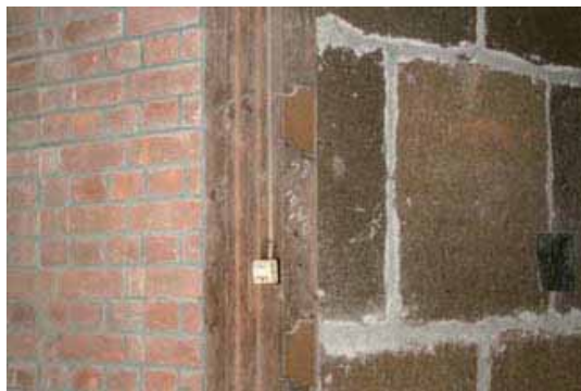
写真6 煉瓦倉庫 外壁面と内部
