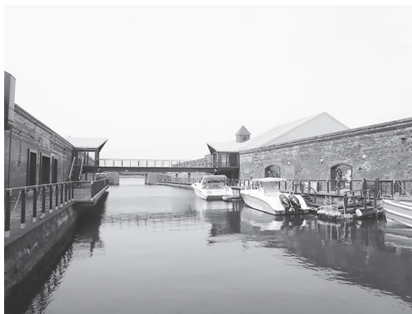
写真1 赤レンガ倉庫
