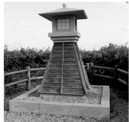
写真3. 1636年から1872年まで現役であった燈明崎の行燈式灯明台：復元
