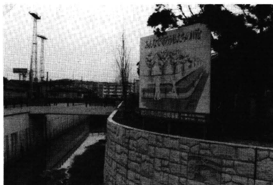
1991年度の河川改修区間。右岸にレリーフ入り護岸が使われている（JR幡生工場前）。
