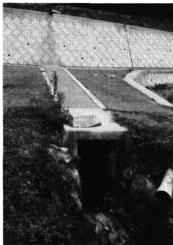
武久川の源流（下関市藤ヶ谷）。水は林道の下につくられたコンクリート・ボックスから流れ出る。
