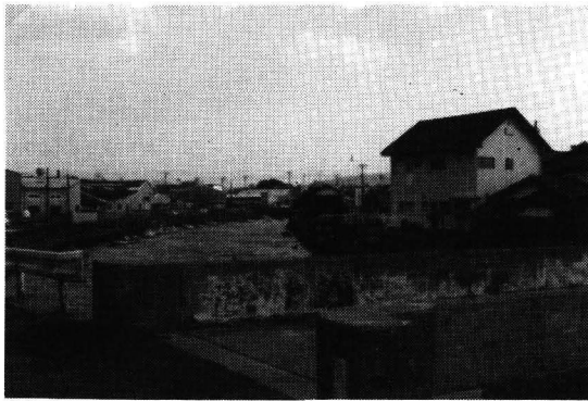
観海橋（手前）から汐入橋方面。
