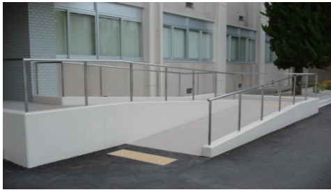
図7 学校本館入口（バリアフリー対策済み）
