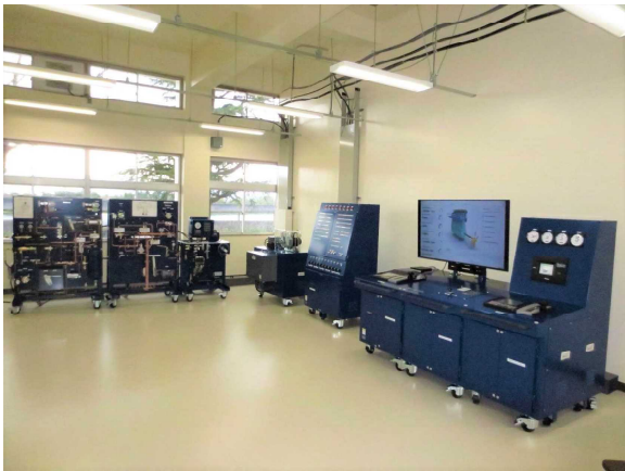
図1 シミュレータ装置全体
