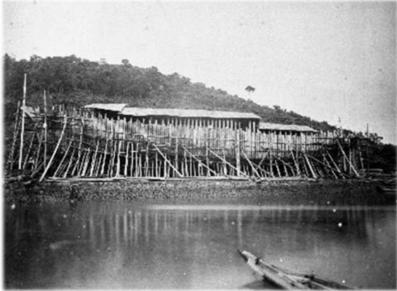
図7 建造中の小菅丸 (三菱重工業長崎造船所蔵) 明治14年
