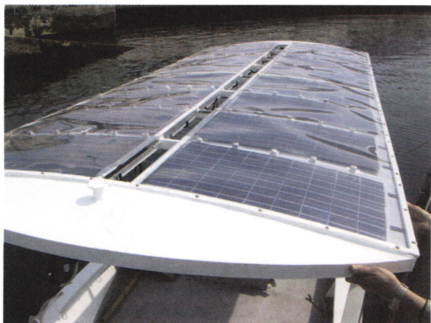
図18 改修後の屋根
