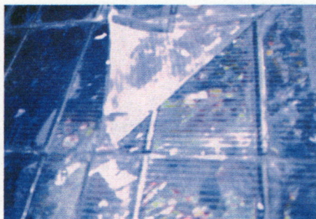
図1. 剥離した太陽電池モジュール
