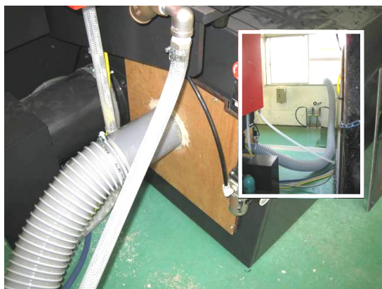
図 15 自作排気口フランジと排気ダクト
