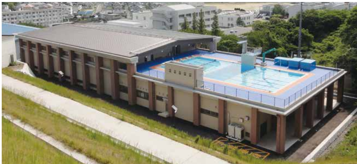
図8. 多目的教育棟. 平成24年度竣工。
