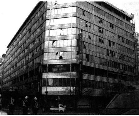
ガラスが割れて多数落下した福岡ビル
