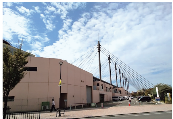
西日本総合展示場 1977年竣工 (筆者撮影)
