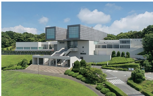
北九州市立美術館 1974年竣工 (北九州市 HP より)
