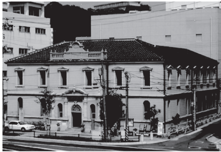
下関南部町郵便局庁舎 (旧赤間関郵便電信局) 明治33 (1900)年/通信省(三橋四郎)
