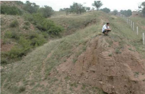
写真4. 趙長城の版築構造
