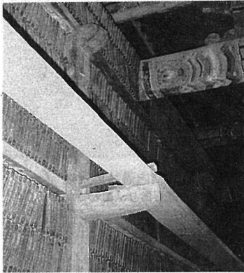
写真5 収蔵庫内部 (上部の版木の取出しのための足場が写っている。梁には仏像が丹青してある)
