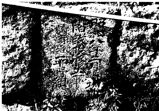
写真3 亀山宮南石段・昭和八年改修工事銘石
