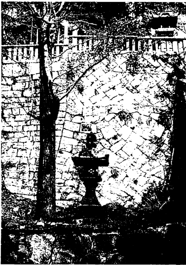
南石段脇・石垣の補修跡
