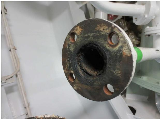
図3 内部腐食の進んだ海水管
