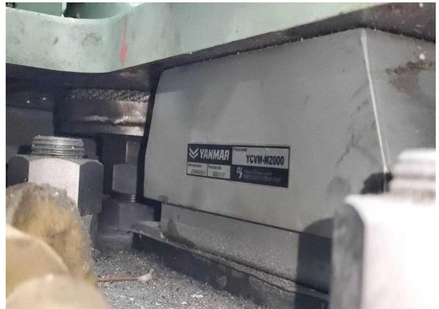
図2 金属ばね防振装置
